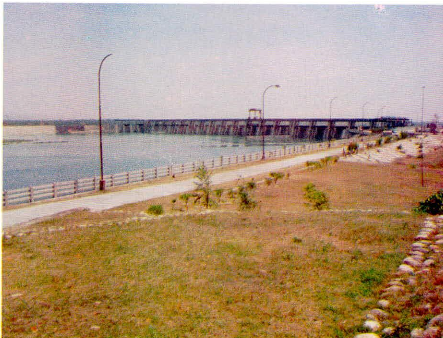
Plate 2. Hathni Kund Barrage
