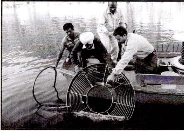
नैनीताल झील में वातन तन्त्र की स्थापना
