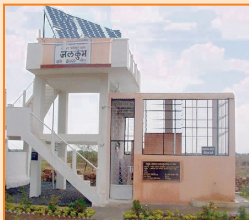
सीएसआईआर- नीरी द्वारा विकसित इलेक्ट्रोलेटिक डिफ्लोराइडेशन संयंत्र।
