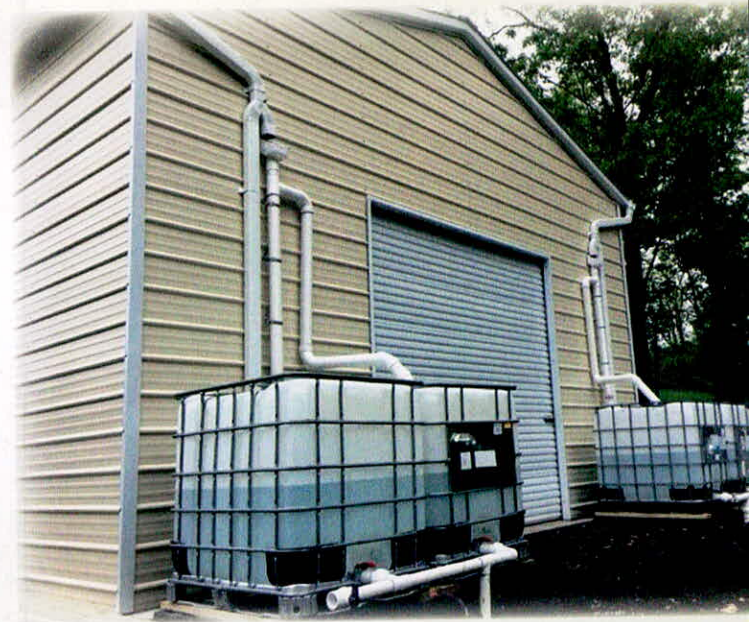
वर्षा जल संरक्षण के लिए घरों में छोटे जलाशयों या टैंकों के निर्माण की आवश्यकता है
